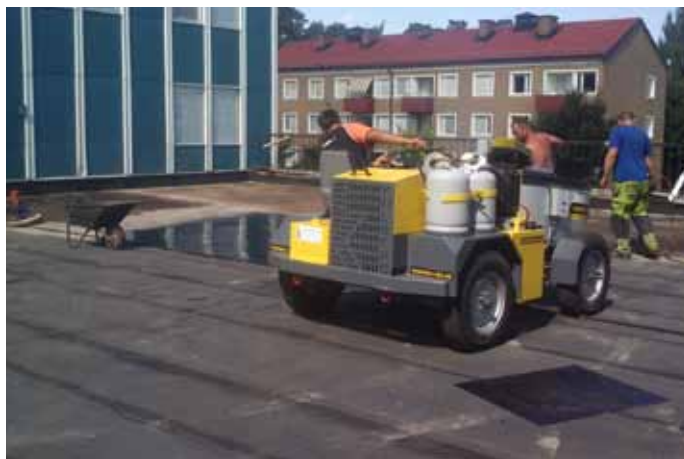
Dumper med inbyggd varmhållning används vid större arbeten.
