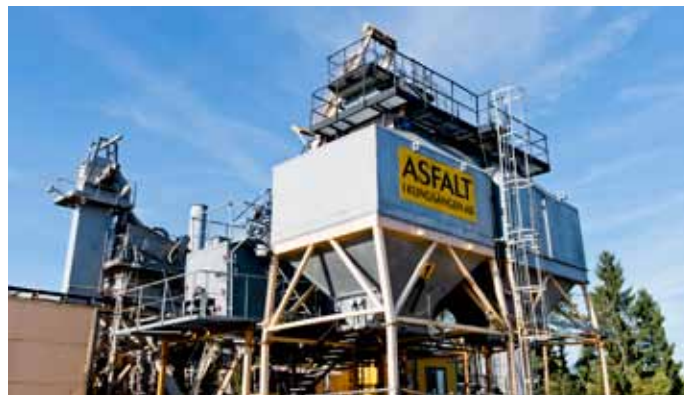
Gjutasfalten tillverkas vid koncernens eget asfaltverk i Kungsängen.
